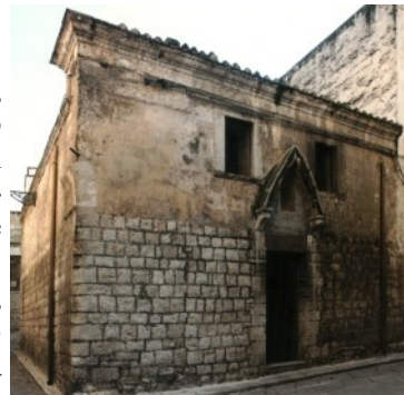
S. Angelo de' Meli, prima del restauro
